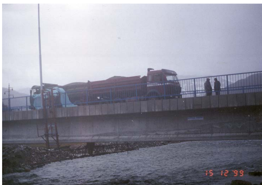
Slika 2. Raspored vozila za šemu opterećenja 2
